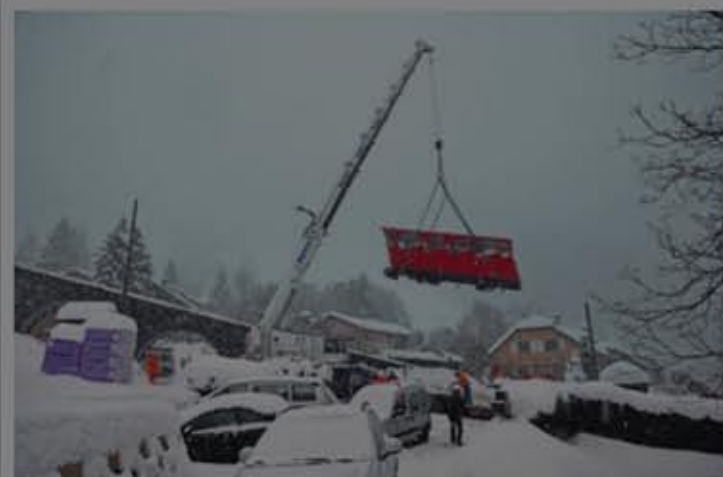
La voiture No 2 a retrouvé ses rails d'origine le 10 décembre sous une neige battante. Une forme de renaissance. DR
